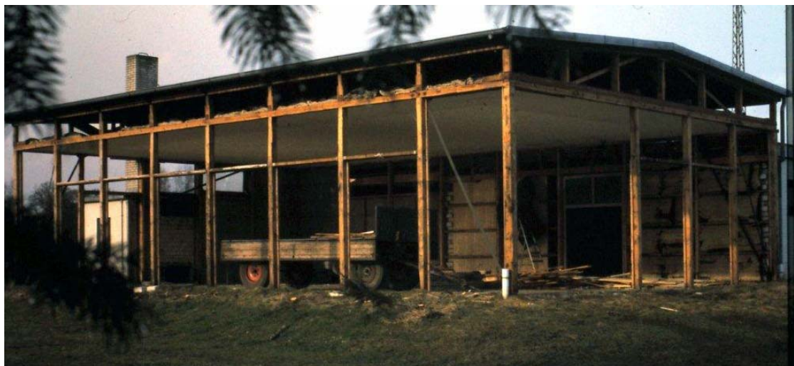
Die alte Halle wurde Stück für Stück abgerissen.
