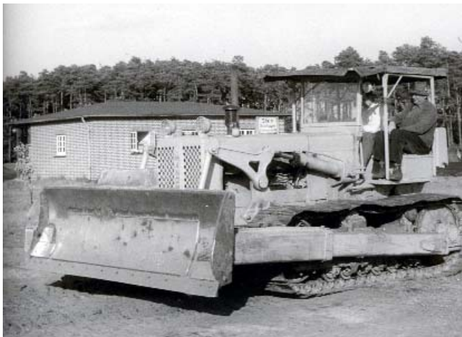
August 1964: Planierungsarbeiten auf dem Sportplatz. Im Führerhaus sitzt der Erste Vorsitzende Gustav Meyer.
