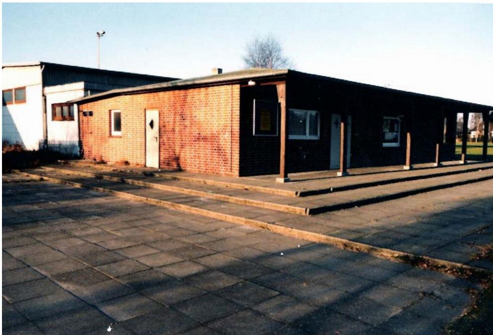
Die neue Halle wurde von hinten an das bestehende Umkleidehaus angebaut.
