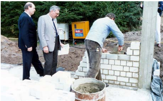
Architekt Volker Jensen (links) und Peter Wind (daneben) auf der Grundsteinlegung der neuen Halle.
