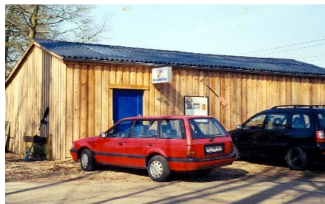
Die Kanuten des MTV haben einen Weideschuppen am Suhrfeldweg zu einem Bootshaus umgebaut.
