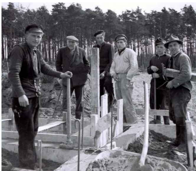
Das Fundament des Umkleidehauses wird gelegt: (von links) Ewald Gastorf, Gustav Hinrichs, Hermann Albers, Walter Gerdau, Herbert Meyer, Heinz Kröger.
